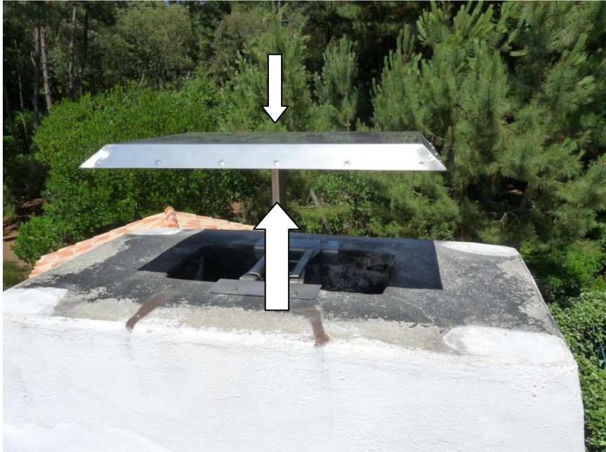
Appuyer sur le volet vers le bas et faites descendre le mat, le volet doit être capable de remonter franchement sans intervention humaine, si ce n'est pas le cas, rajouter un peu de sable dans le contrepoids jusqu'à y parvenir.
