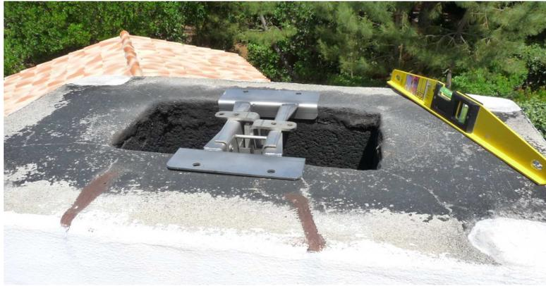
Une fois bien positionné, repérer à l'aide d'un crayon l'emplacement des trous à faire dans la souche pour les 4 fixations
