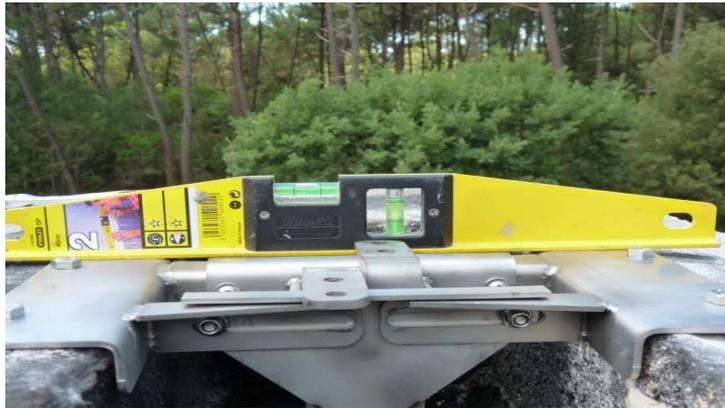
Ajuster s'il y a lieu, à l'aide de rondelles en inox sous le mécanisme afin d'obtenir cette verticalité obligatoire pour un bon fonctionnement de la trappe
